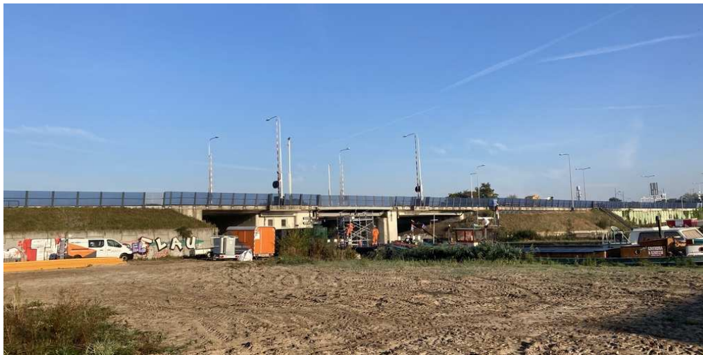
Huidige brug met bouwplaats aan zuidoostzijde.
