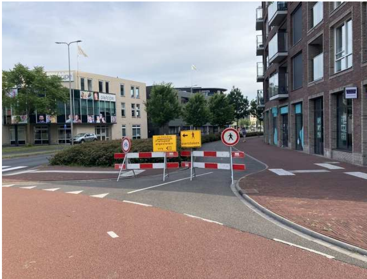
Hek op fietspad na afloop van het werk.
